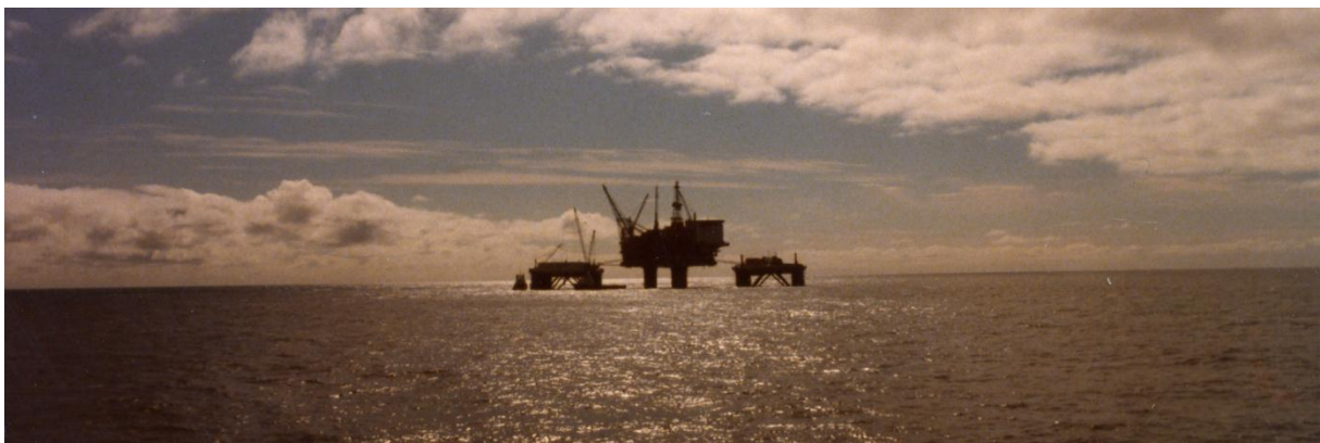
Statfjord A under oppbygging. Fotograf: Odd Noreger.
